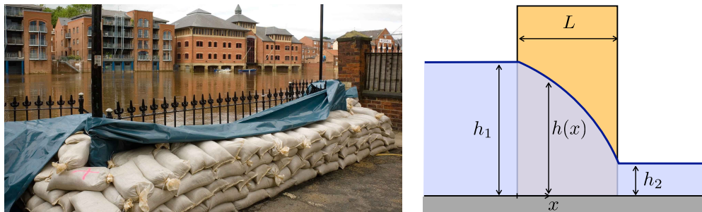
Figure 2: Gauche: Barrière de protection contre une crue réalisée avec des sacs de sable (source : zurich.com). Droite: Version simplifiée ; le mur de sable de largeur L comprend une partie saturée d'eau de hauteur locale h(x) dans laquelle l'écoulement se produit. Cette zone est surmontée d'une région considérée comme sèche (on néglige ici les effets de la capillarité).
