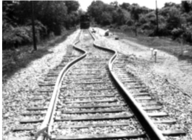
**Fig. 0.1** – *Flambage de rails sous l’effet de la dilatation thermique. En Suède les températures peuvent en effet varier de  $-40\text{ }^{\circ}\text{C}$  à  $+55\text{ }^{\circ}\text{C}$  entre l’hiver et l’été.*
